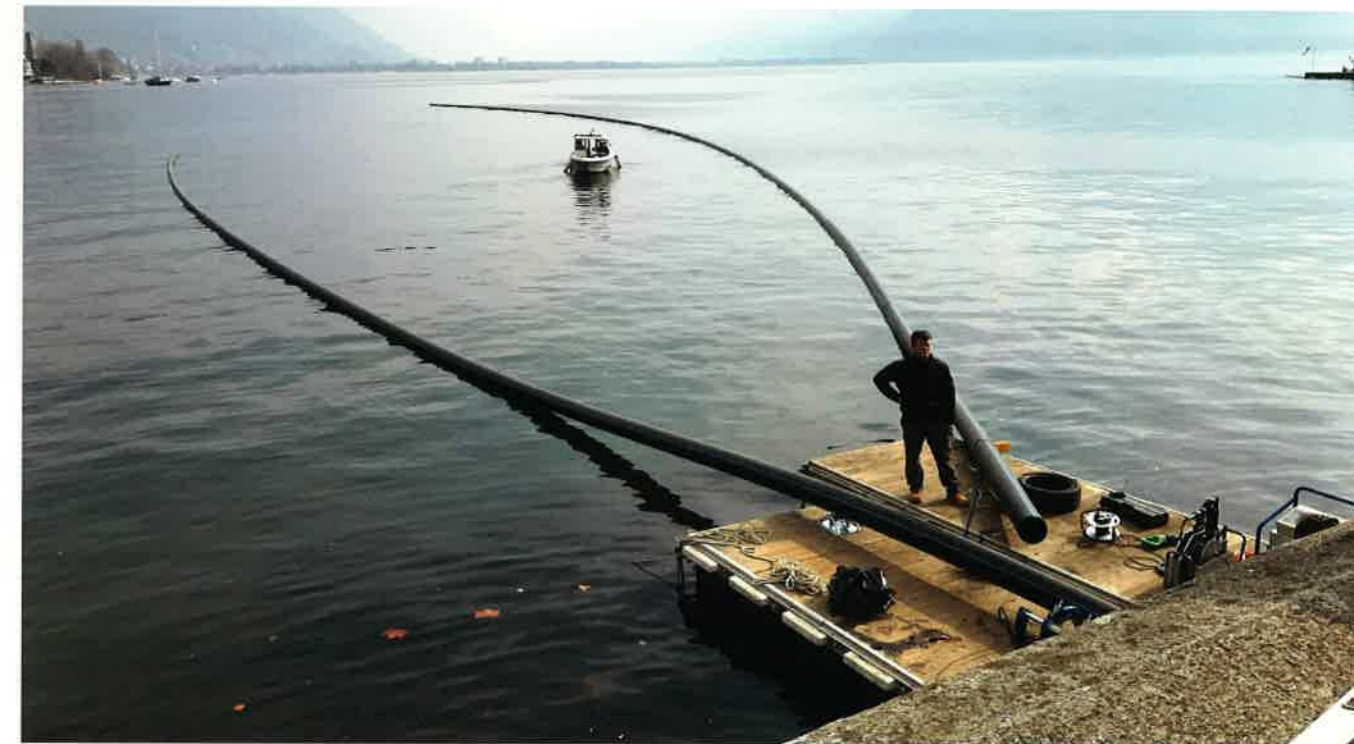
Posa tubazioni di captazione
